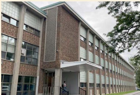
Figure 14 — Vue sur l'école Arménienne Sourp Hagop située au 3400, rue Nadon. Photo : M.-A. Larouche, 2024.
