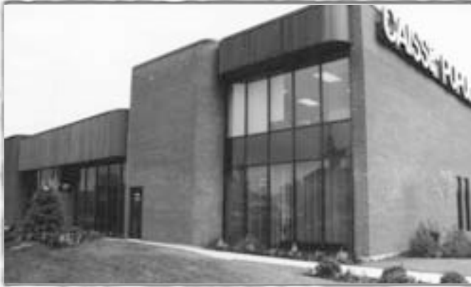
1986. La rallonge complétée ajoute un étage et un sous-sol du côté sud de l'édifice de 1977.
